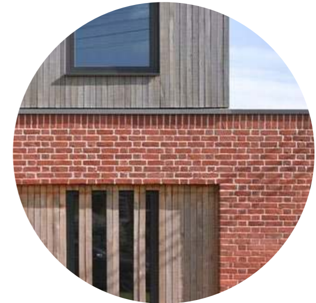
Materiale skift i facaden.
